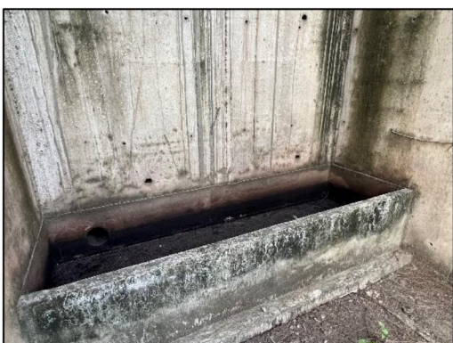
รูปที่ 9 รางระบายน้ำล้อมรอบลานกองเก็บขานอ้อย
