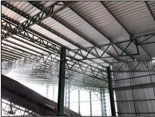
รูปที่ 6 การฉีดพ่นน้ำขานอ้อยในจุดปรัยกอง
